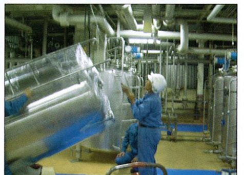
工場内の安全・迅速な定位置据付工事
